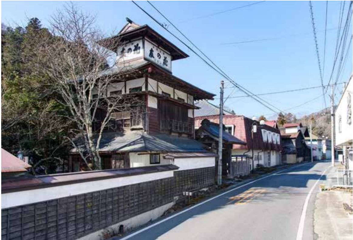
外観（北側道路側から）
