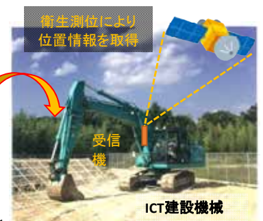
3次元設計データを建設機械に搭載
