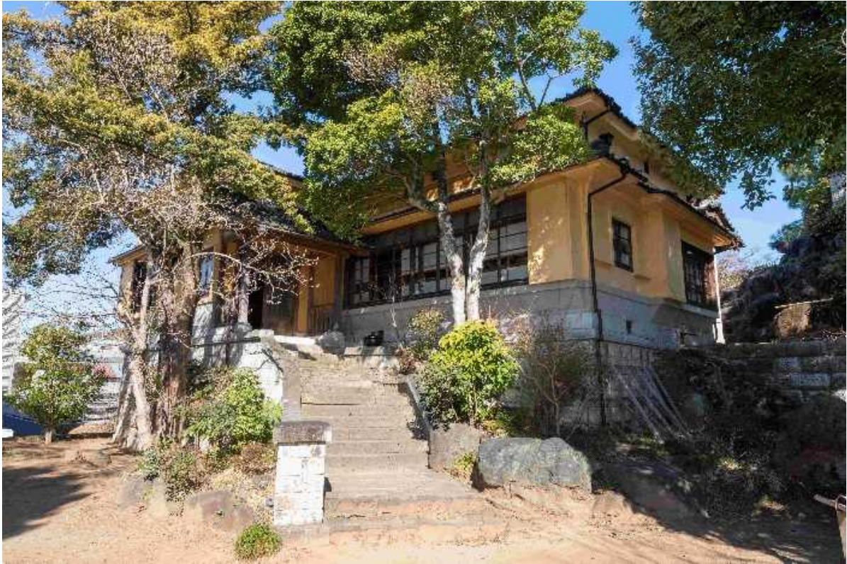
本館正面（南東面）外観
