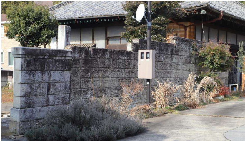
川田家住宅石塀及び板塀
